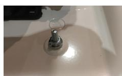
Inserire il cavo con occhiello alla Vite di terra e fissare il tutto con un'altra rondelle e dado.
