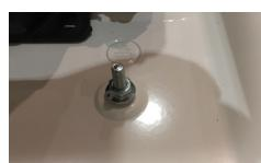
Gör en öglia på kabeln och placera den runt jordningsskruven och fäst alltsammans med en annan bricka och mutter.
