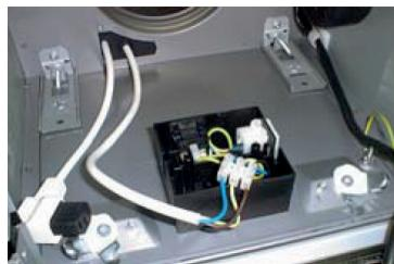
Der gelb-grüne Draht, falls vorhanden, wird an der Erdschraube der Haube fixiert; auf gleiche Weise wird der gelb-grüne Draht am entfernten Abzug an die Erdschraube des Abzugs angeschlossen.
