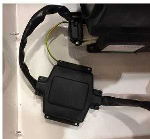
Inserire la Vite per la messa a terra dall'esterno verso l'interno avvitando rondella e vite come indicato.
