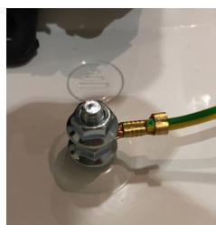
A questo punto verificare la lunghezza del cavo di collegamento di cui si necessita ed eventualmente tagliare la parte in eccedenza.
