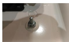
Das Kabel mit der Öse in die Erdschraube stecken und das Ganze mit einer weiteren Scheibe und einer Mutter befestigen.
