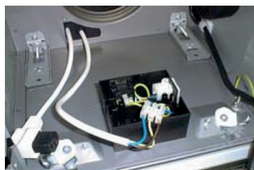
Jeśli pozostał nam kabel żółty/zielony, należy go przymocować do śruby uziemienia okapu. W ten sam sposób połączyć ze śrubą uziemienia kabel żółty/zielony znajdujący się w ssawie zdalnej. Płytkę zaciskową umieścić w puszce instalacji elektrycznej. Wszystkie kable umieścić po bokach.
